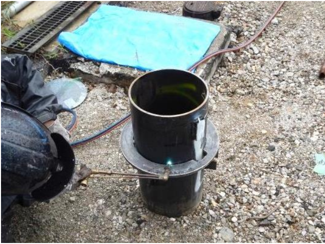
1 鋼管打設後、杭の頭を切断
