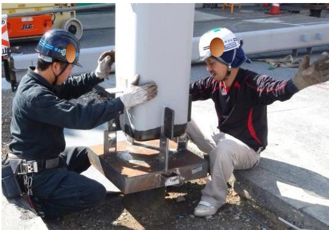
5 即、鉄骨柱取付
