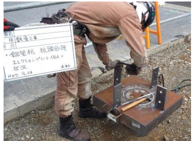
4 エレクションプレート仮止め
